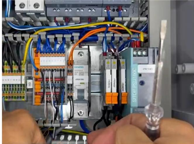
2. A1 Kontakt aus altem 3QB1(3KFA1) Relais lösen -> am neuen A1 Kontakt befestigen
