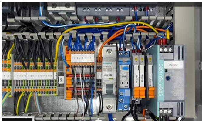
4. „14“ von 3QB1(3KFA1) lösen -> am neuen Relais „14“ befestigen
